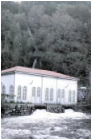
Minicentral hidroeléctrica do Zarzo
